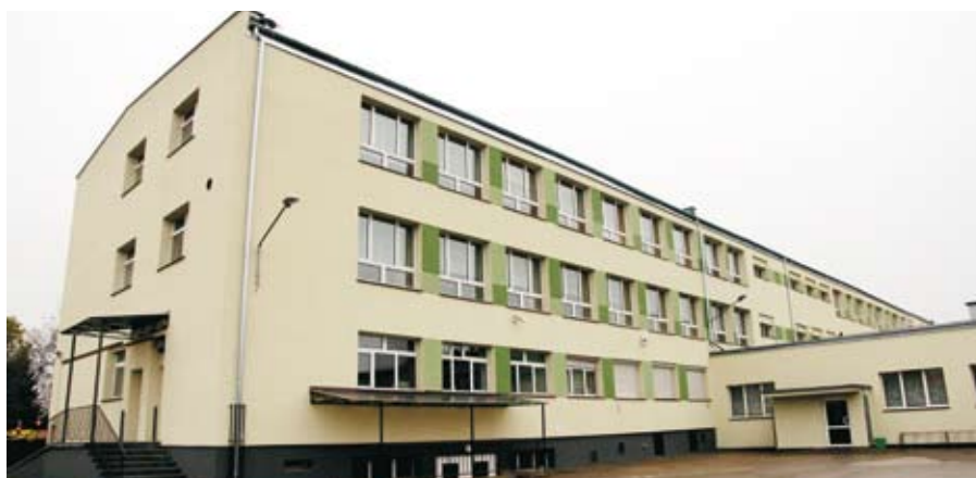
Budynek Zespołu Szkół Samorządowych w Ełku po zakończonej termomodernizacji.
