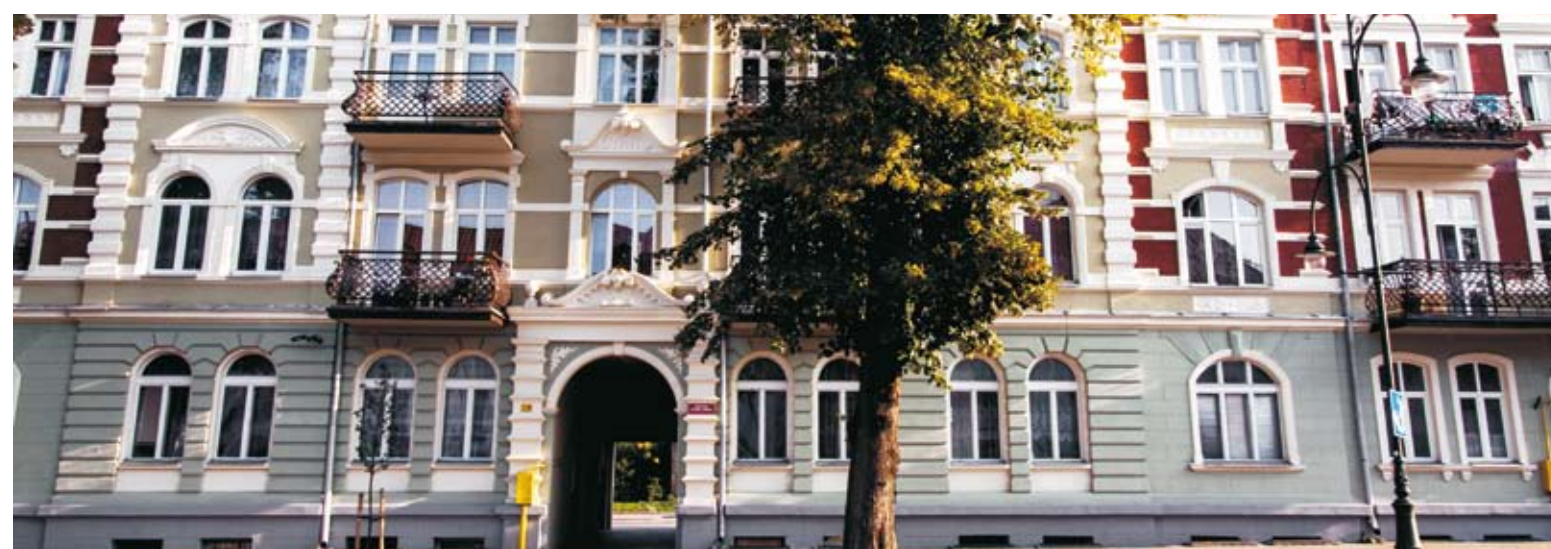
Kamienica przy ul. Mickiewicza bezpośrednio po remoncie
