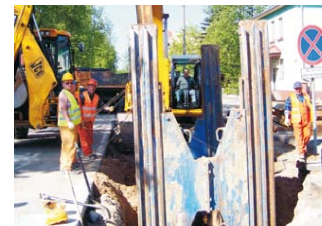
Kanał deszczowy na ulicy Mickiewicza
