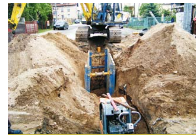
Prace PWiK na osiedlu Grunwaldzkim
