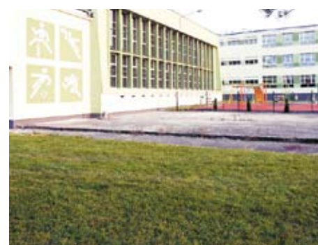
Termomodernizacja ZSS w Ełku
