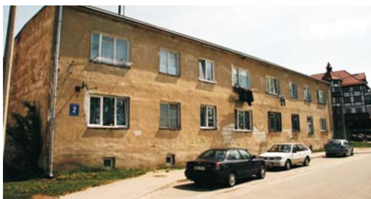
Budynek przy ulicy Pułaskiego przed remontem
